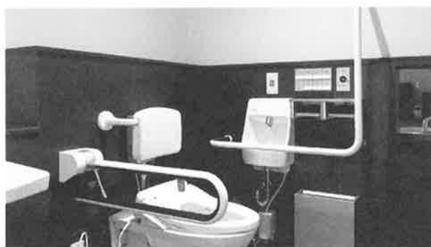
図2 「新型愛の手オーバル」の設置状況
