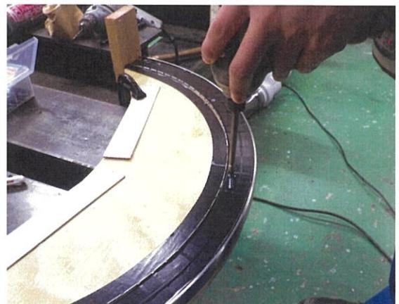
金台を階段へ取り付け、端部より順にビス固定してください。
