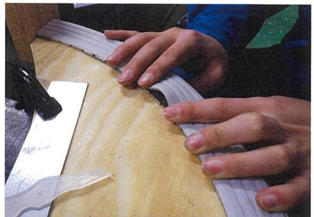
※端部の嵌合については残り 300mm 程度まで嵌合した後、先に金台端部から嵌合していき、最後に残り分を押し込み嵌合してください。
