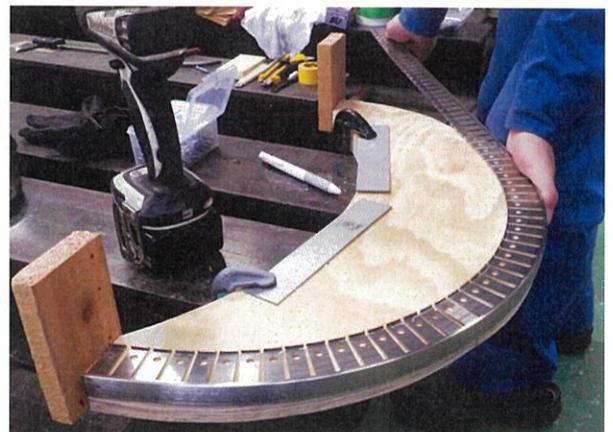
金台端部をビス止めし、階段段鼻に金台を押し当てながら曲げていき、曲げ癖をつけてください。
