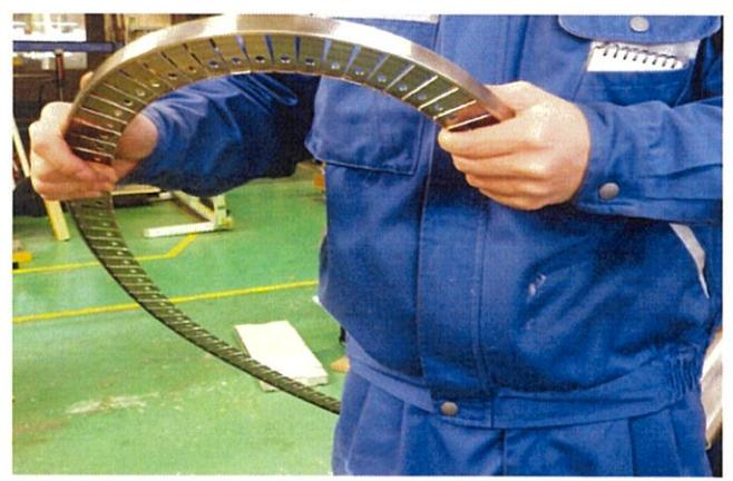
金台端部より 150mm 辺りを手で階段 R に合わせて曲げてください。
